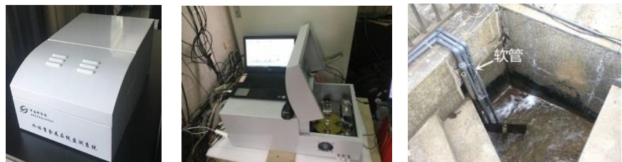
2017年，某冶炼厂排放废水重金属在线监测应用
